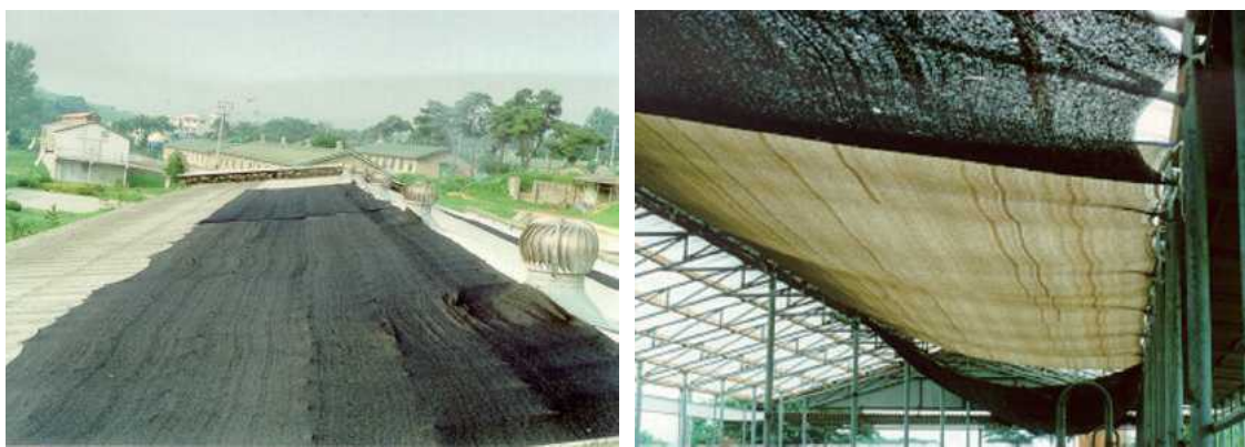
그림 4 축사지붕 및 축사 내에 차광막을 설치한 장면
