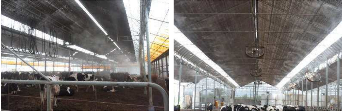
그림 6 축사 내 안개분무장치 가동 장면
