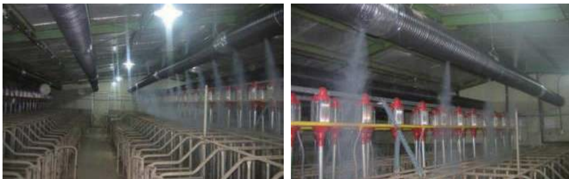
그림 10 돈사내부 환기를 위한 덕트 설치
